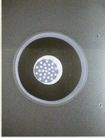
1階東廊下 トップライト
