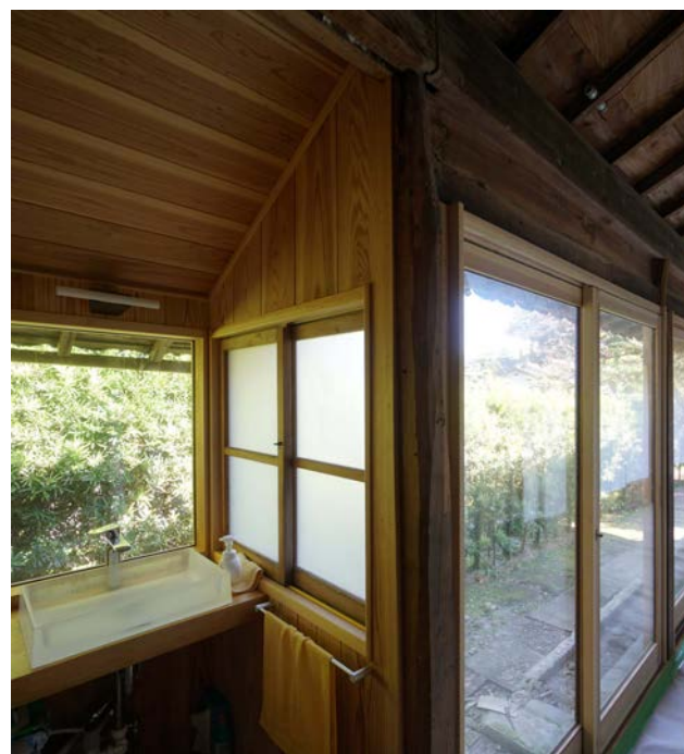
トイレもすべて乾式化し再生。建具は旧便所等の建具寸法を修正し活用。
