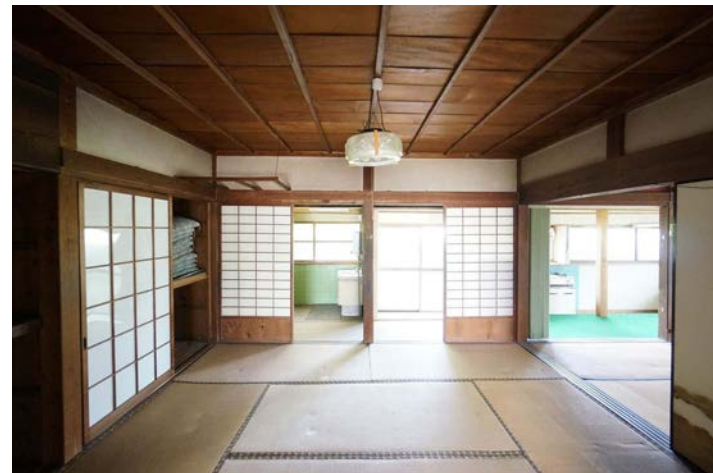
改修前のナカザ 縁側外側に増築され床下通風ができない状態
