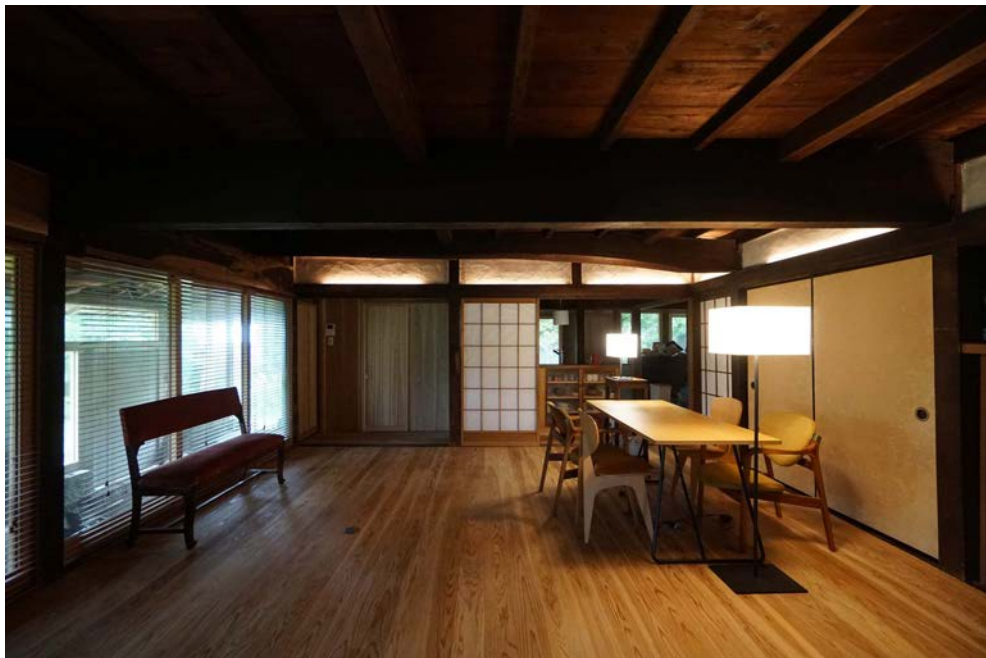
畳敷のカミザは、床断熱を行い地元産の杉板張りの床とし鴨居に間接照明を設けた
