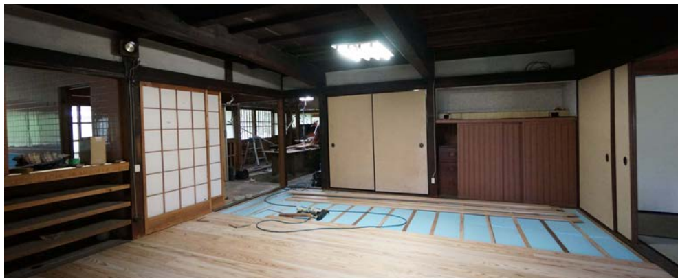
床断熱施工中の状況
