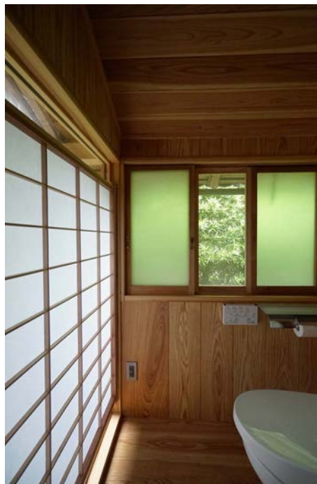
トイレもすべて乾式化し再生。建具は旧便所等の建具寸法を修正し活用。
