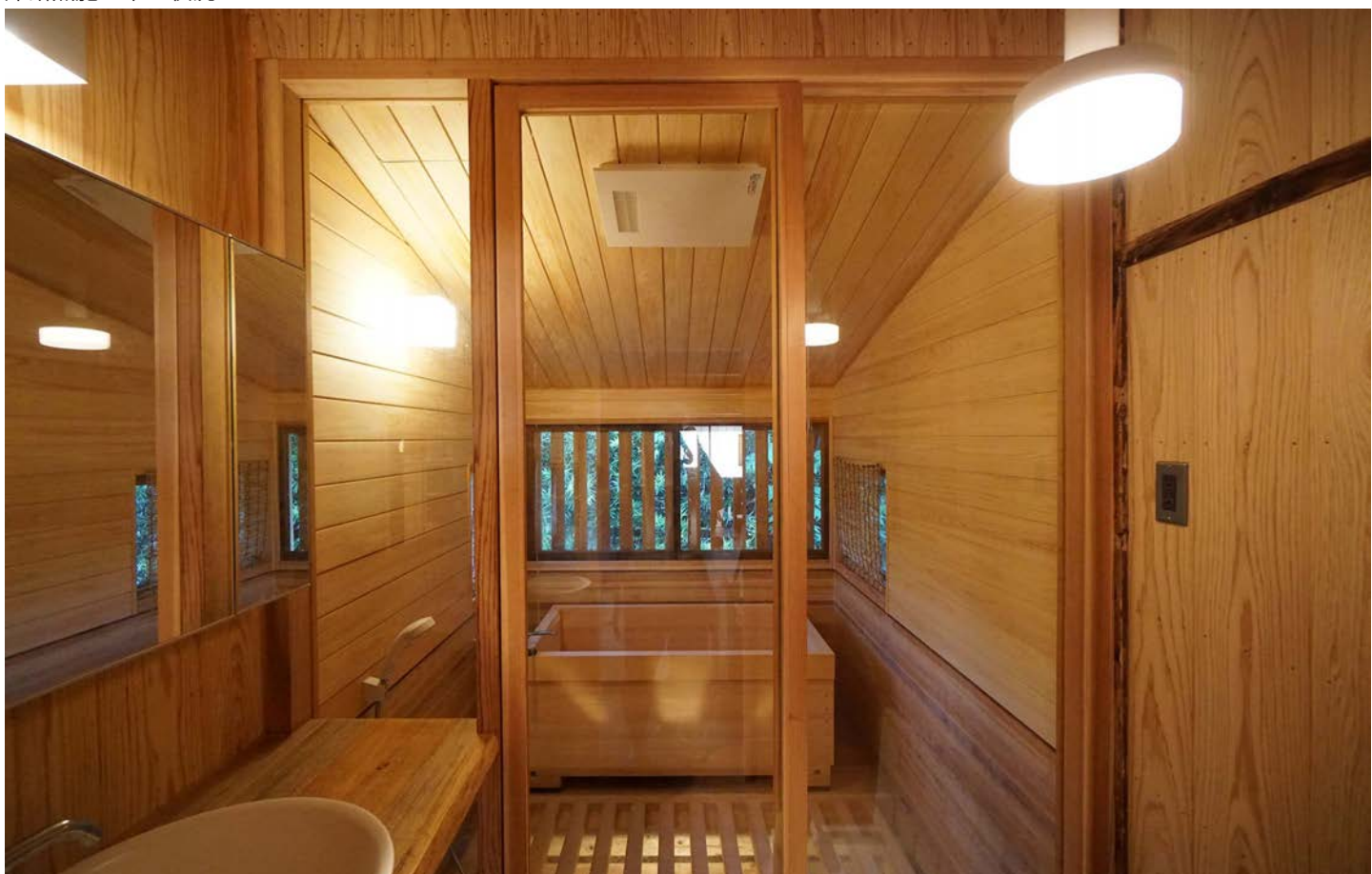
水回りはすべて乾式化し再生。浴室床は五右衛門風呂の釜が出てきたためポリカーボネートの透明床とした
