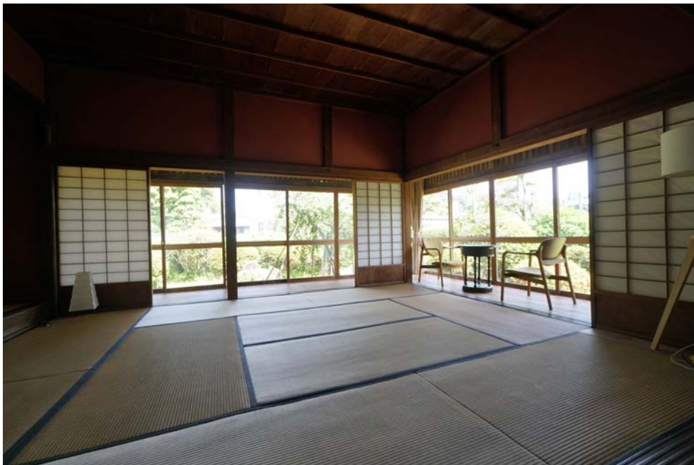
ザシキは保存部分 縁側は解体し杉板 / 断熱 / 元のイヌマキの縁甲板でバリアフリー化
