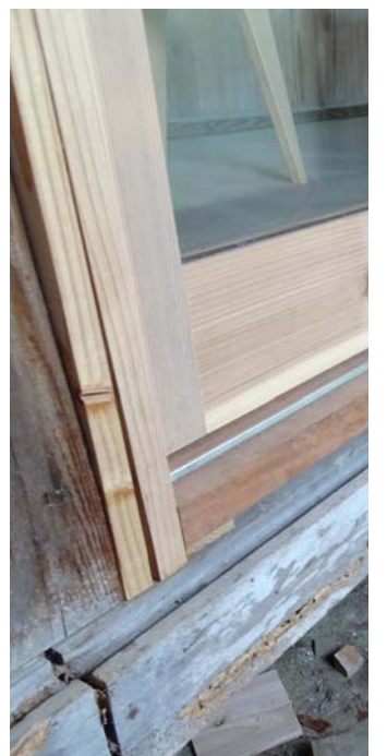
枠と柱の間の傾き補正材と旧雨戸敷居
