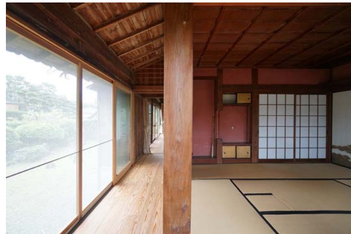
修復再生後の縁側 床は断熱し建具はすべて複層ガラス化
